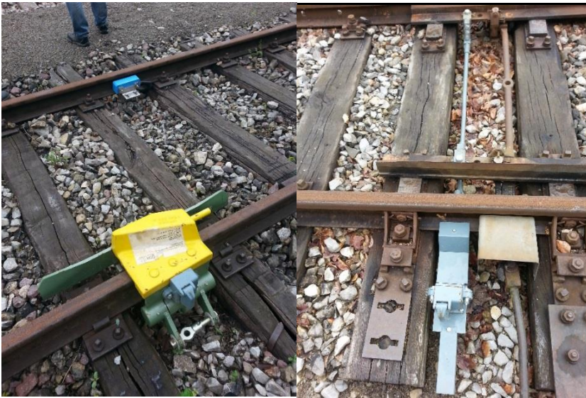
Abbildung 16: Gleissperren- / Weichen-Verschlusseinrichtung (HVE)
